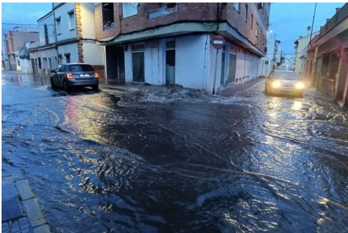
Reventón de tubería en la avenida Menéndez Pelayo de La Línea.
