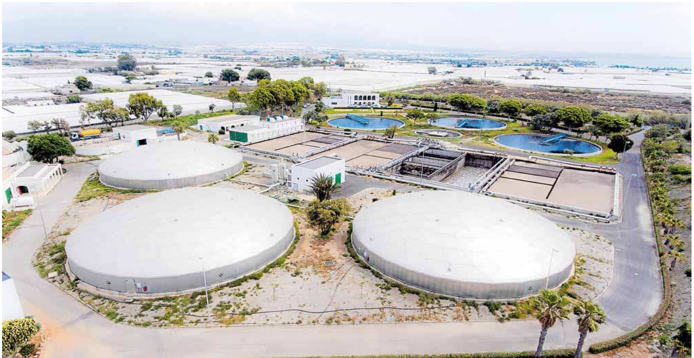
Vista aérea de la EDAR de El Bobar de Almería, en una imagen de archivo de Aqualia. R. I.
