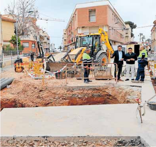
Nueva Estación de Bombeo de Aguas Residuales, en Lo Pagán. AYTO.
